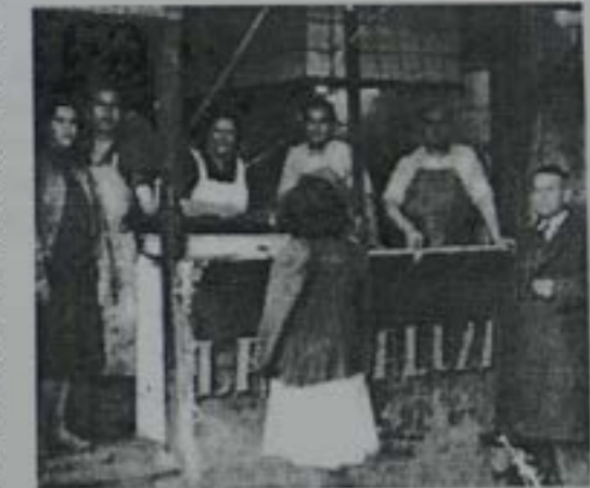
«La Andaluza» en el primer puesto de la calle Tiziano
